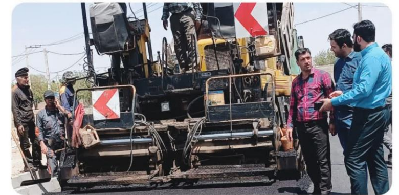
عملیات زیر سازی و آسفالت خیابان ۱۵ خرداد
