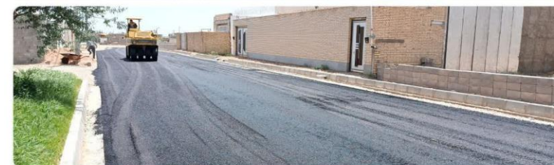
❖ عملیات آسفالت خیابان شهید چمران جنوبی
