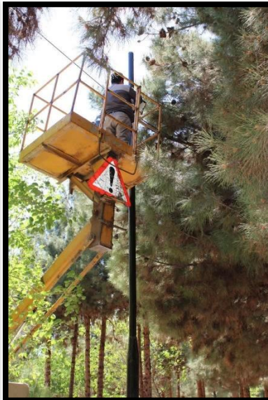
نصب چراغ پارک مجتهد
