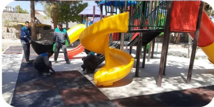
نصب کف پوشی در پارک ها
