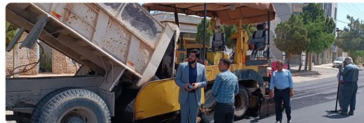
عملیات روکش آسفالت خیابان باهنر
