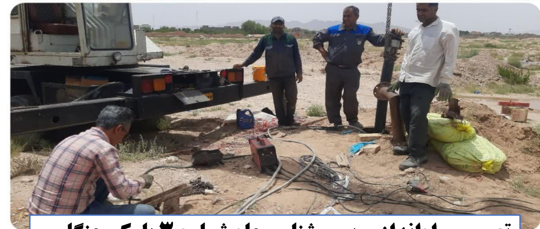
تعمیر و راه اندازی پمپ شناور چاه شماره ۳ پارک جنگلی
