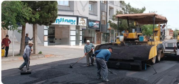
عملیات روکش آسفالت خیابان باهنر
